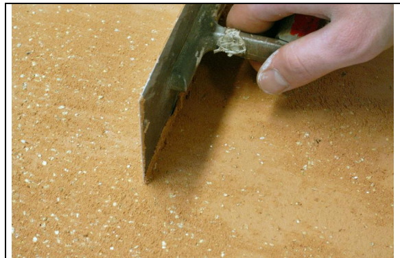
1 % Vermiculite in Kalk Haftputz -fein-, beige getönt, Abziehen mit der Kelle
